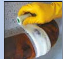
8. Zum Schluss mit der fermit-Dichtbandage, wie beschrieben, umwickeln.
