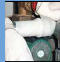
2. Rohr ist drucklos und kalt. Reparaturstelle ist sauber u. feucht. Bandage zügig u. straff umwickeln. (Dicke 6 mm)
