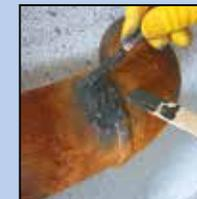
7. Neue Portion anmischen und eine 3-5 mm Schicht auftragen.
